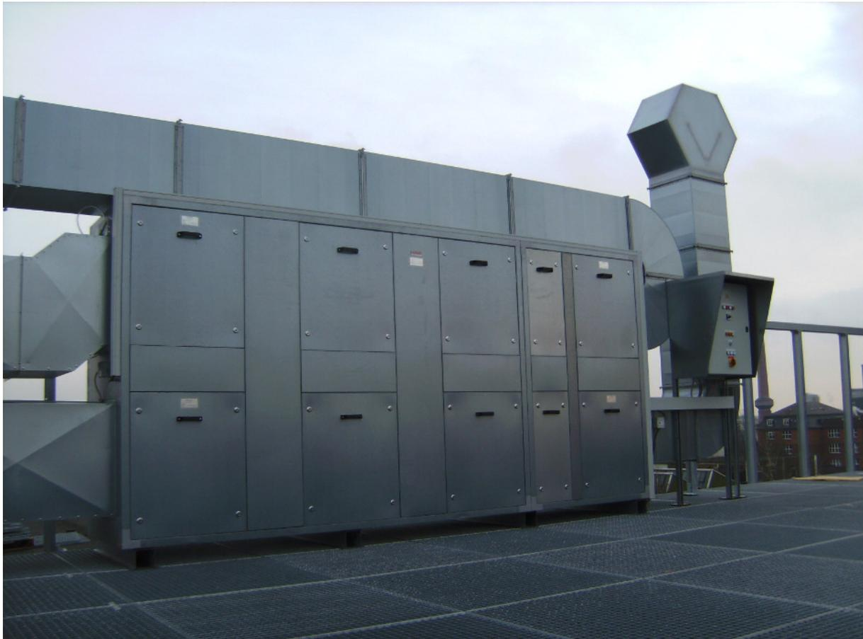
Kombiniertes Zu- und Abluftgerät mit integrierter Wärmerückgewinnung durch Hochleistungs-Gegenstrom-Plattenwärmetauscher mit einem Wirkungsgrad bis über 90 % aus korrosionsbeständiger Aluminiumlegierung.
